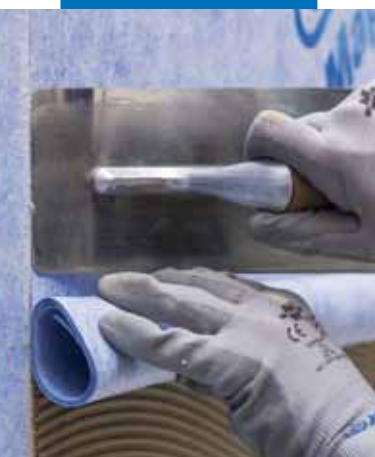
Applikation der anschließenden Bahn
