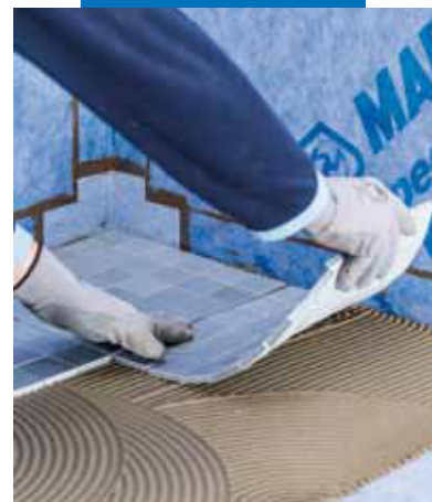
Verlegung von Fliesen
