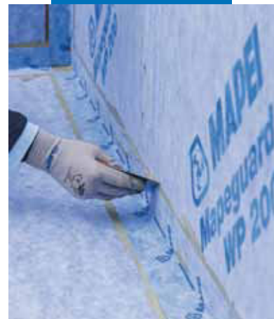
Applikation von Mapeguard ST
