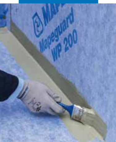
Applikation des Klebstoffs Mapeguard WP Adhesive im Wand-Boden-Bereich vor dem Aufbringen des Dichtbandes Mapeguard ST
