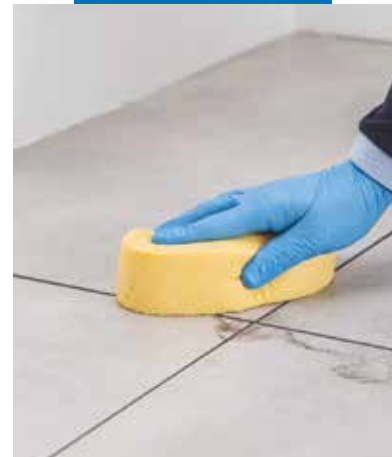
Entfernung von Rückständen von Flexcolor 4 LVT mit einem Schwamm von der Fliesenoberfläche
