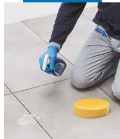
Abschließende Reinigung mit Kerapoxy Cleaner
