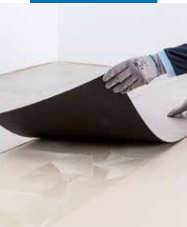
Verklebung von LVT Fliesen mit Ultrabond Eco 4 LVT
