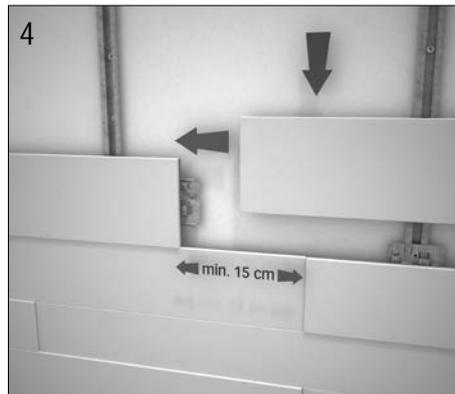
Die erste Reihe TOP 300 M auf das Profil aufdrehen und in die Nut 1 des Panels schieben und arretieren (Abb. 3). Nach dem Ausrichten der ersten Panelreihe die Montageklipp mit Schrauben oder Nieten fixieren, um ein Verschieben bei der weiteren Montage zu verhindern.
